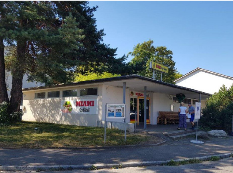
Der ehemalige Quartierladen im Auzelg vor dem Umbau.
